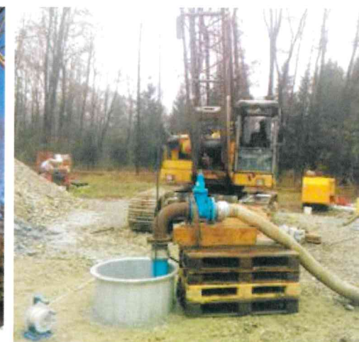
Mit der größtmäßig abgestuften Seilbagger-Flotte können Durchmesser bis zur Nennweite 1.600 mm erstellt werden.
