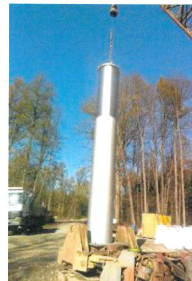
Mit der größtmäßig abgestuften Seilbagger-Flotte können Durchmesser bis zur Nennweite 1.600 mm erstellt werden.
